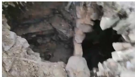
Σημερινή κατάσταση Κούλιας Βουτσικάκι.
